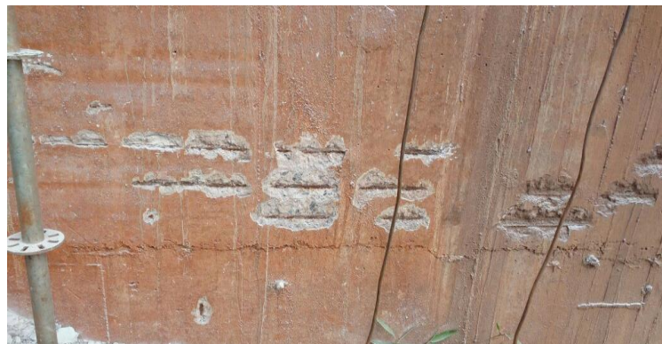
Figura 4 – Início do processo de recuperação das áreas danificadas. Fonte: Dados da pesquisa (2017)
