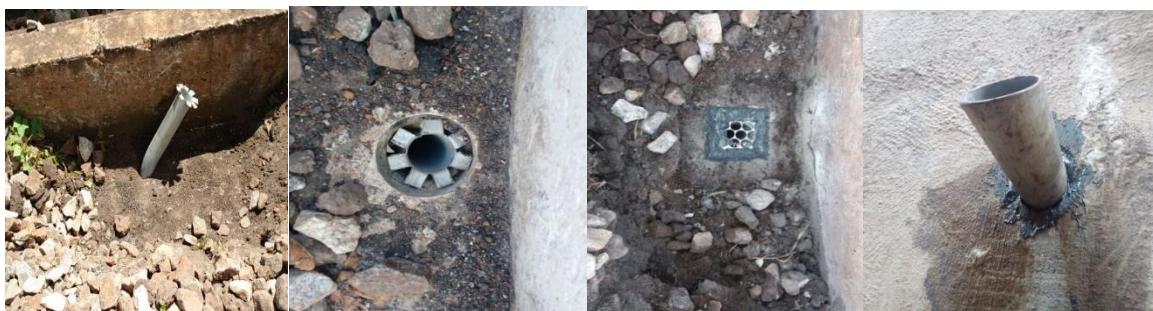
Figura 2 – Instalação de buzino-te. Fonte: Dados da pesquisa (2017)
