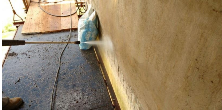
Figura 3 – Lavagem com Hidro Jateamento. Fonte: Dados da pesquisa (2017)
