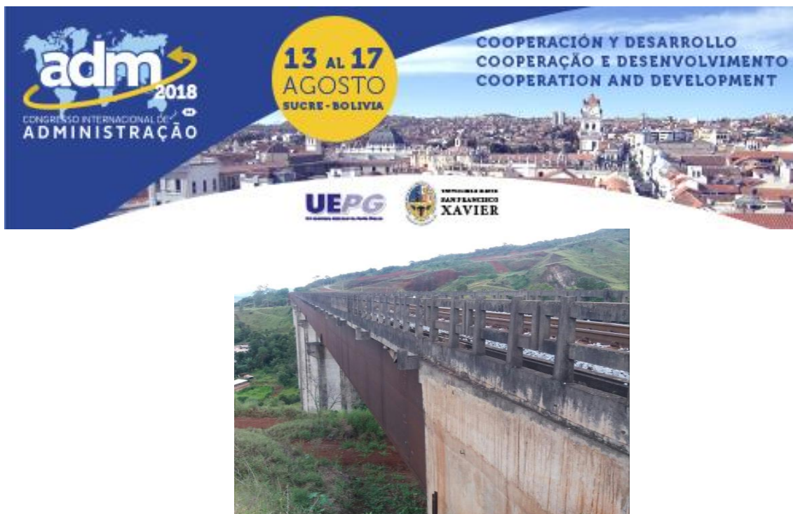
Figura 5 – Parte inferior do viaduto férreo. Fonte: Dados da pesquisa (2017)
